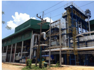
โรงไฟฟ้าพลังงานขยะ
